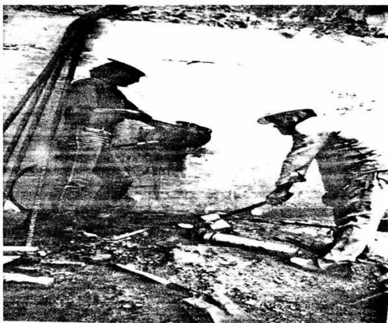
APLICACIÓN DE LA TENSIÓN (25 TON) Y EL REAJUSTE DE LAS TUERCAS.
