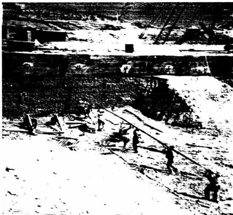
INTRODUCCIÓN DEL TENSOR EN LA PERFORACIÓN.
