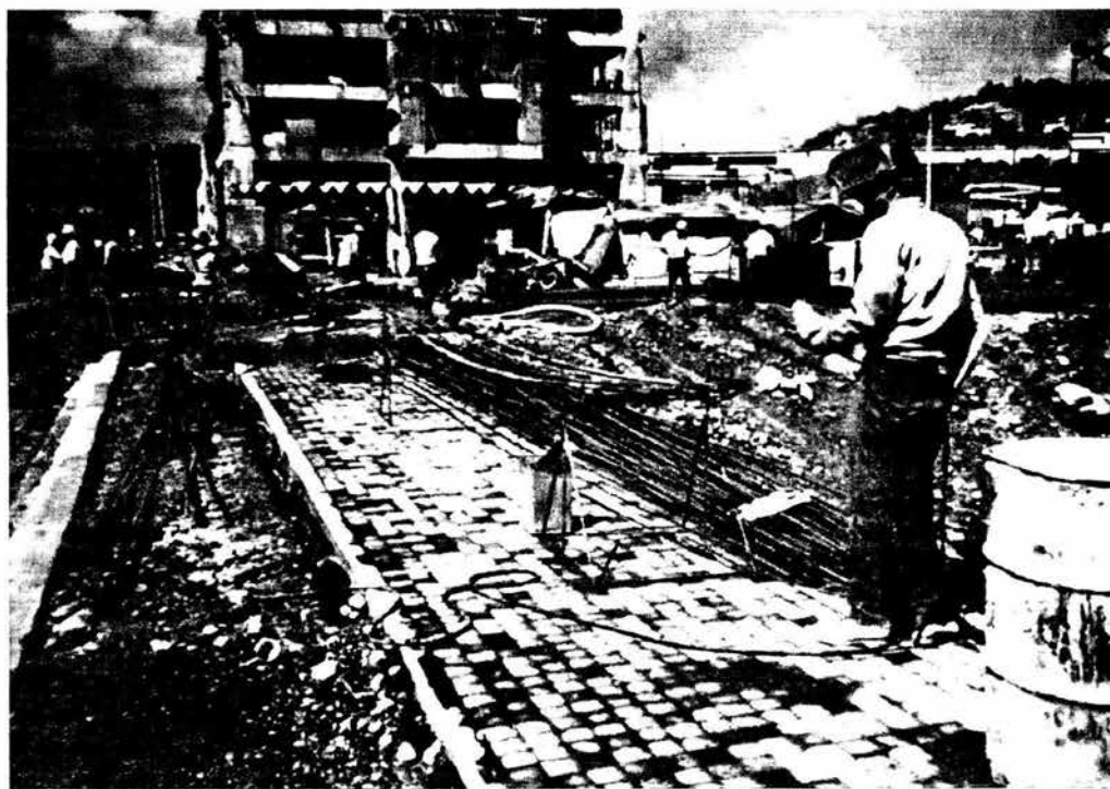
HABILITADO DE LOS TENSORES (ANCLAS) PARA LOS DIFERENTES NIVELES DE ANCLAJE.
