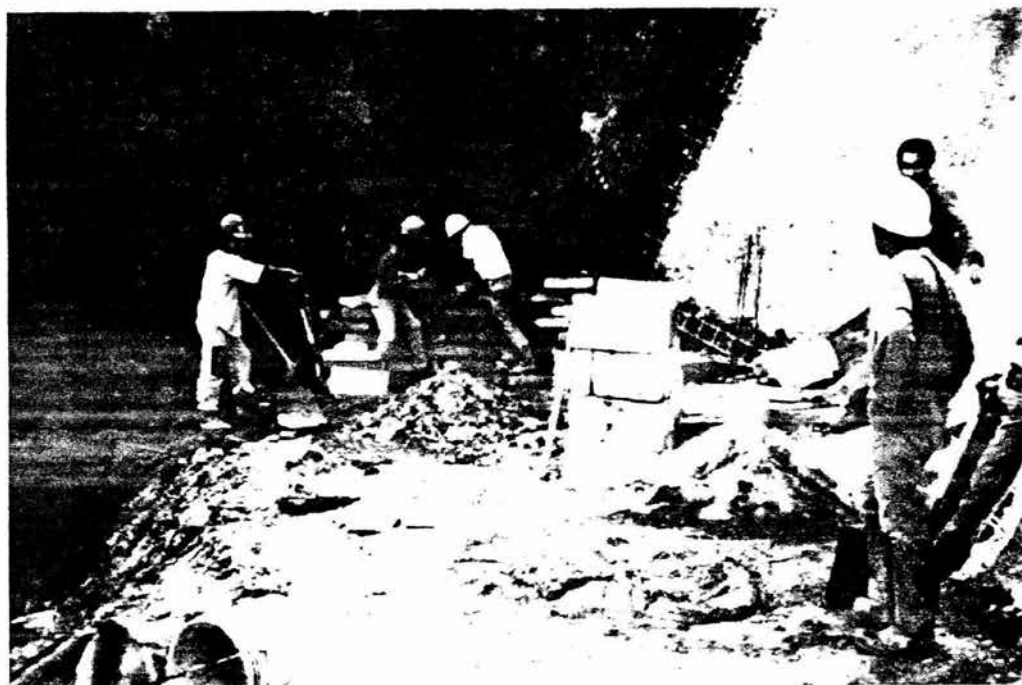
TRABAJOS DE RESTITUCIÓN DEL MATERIAL DESLIZADO (DESCONCHAMIENTO LOCAL) A BASE DE TABIQUE LIGERO UNIDO CON MORTERO.
