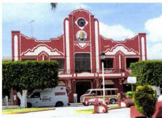
Fig. 17. Palacio Municipal de Progreso de Álvaro Obregón.
