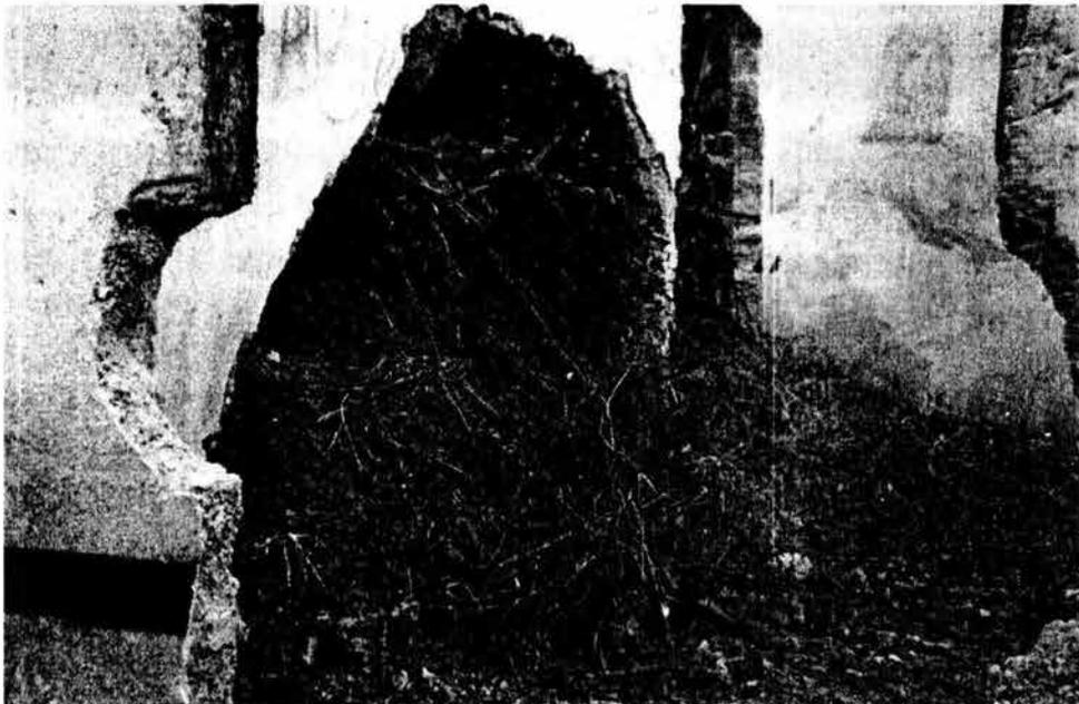
Figura 3.16. Pared destruida a causa de un deslizamiento en la proximidades de la población de Hueytepec.
