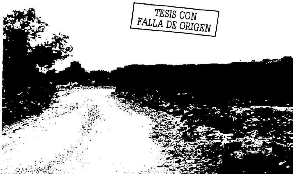
Carretera a San Francisco que pasa por el costado este de San Antonio
