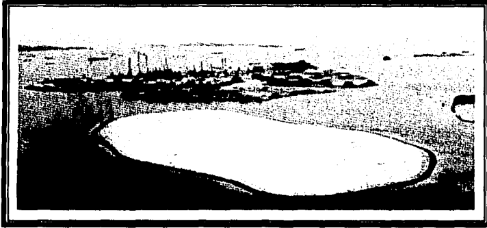
Fig. 46a Isla artificial construida con producto del dragado.
