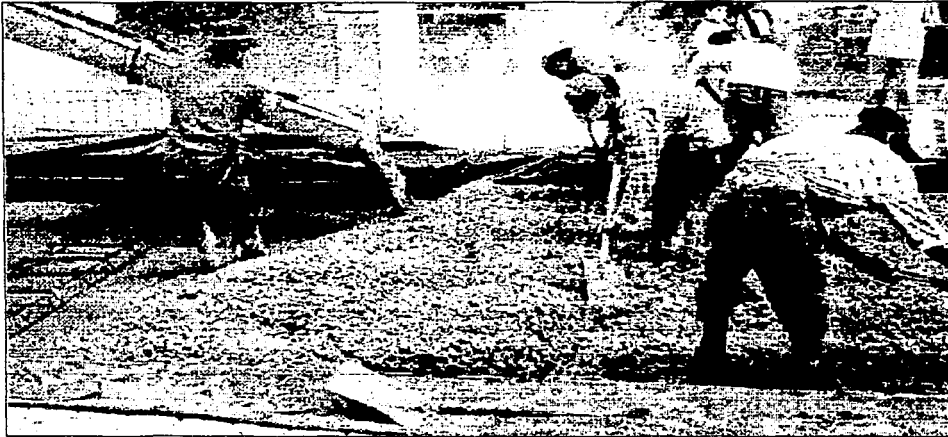
FIGURA II.12 PROPORCIONAMIENTO DE CONCRETO PARA REPAVIMENTACION A BASE DE CONCRETO HIDRAULICO, MEXICO D.F. DE 2002.
