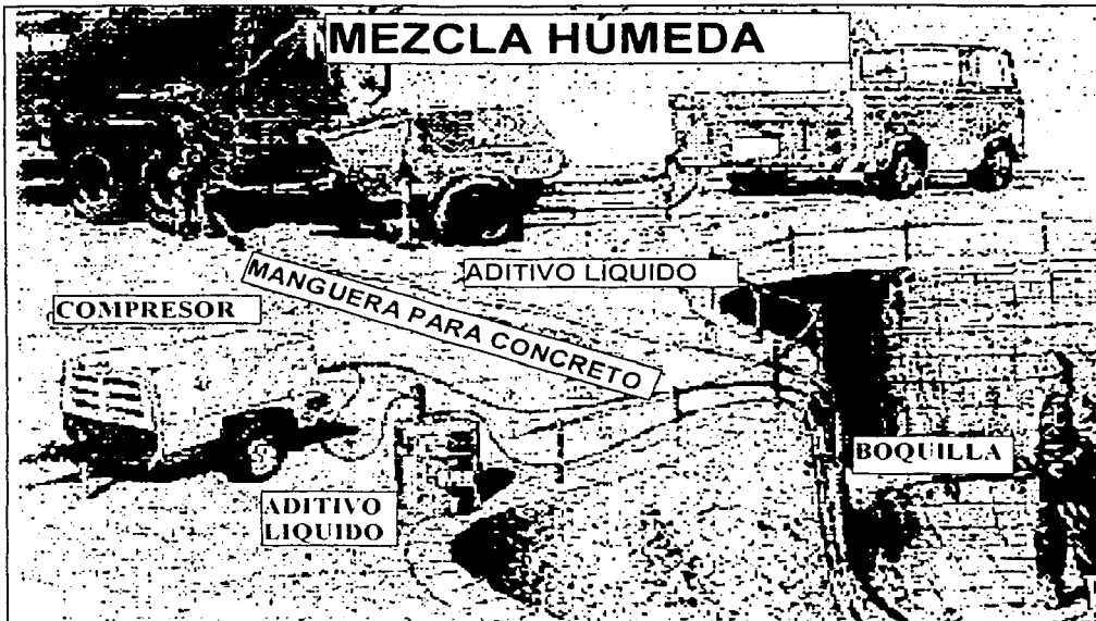
FIGURA I.2 CONCRETO LANZADO POR VÍA HÚMEDA
