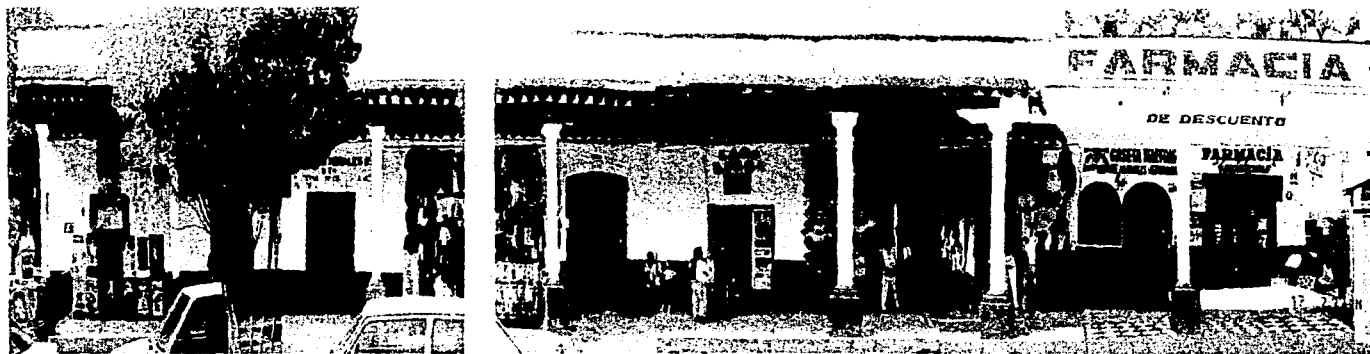
Vista del portal en la plaza principal sobre la calle de Guillermo Prieto.
