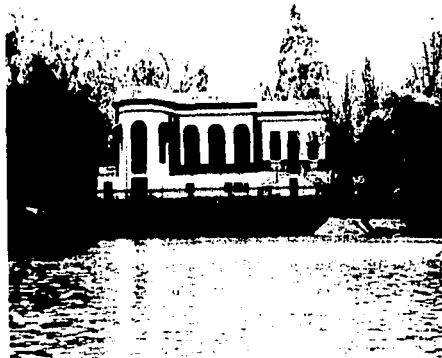
DETALLE DE LA CASA DEL LAGO
