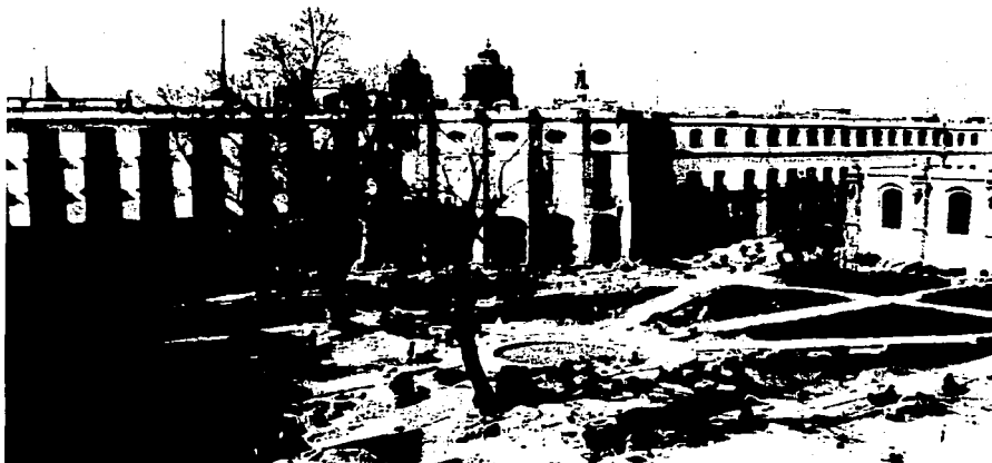
60. Jardín de Palacio Nacional. Proceso de las labores de intervención de restauración.
