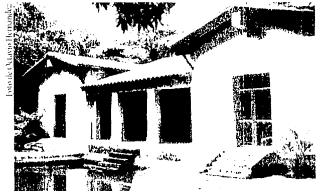
❖ Portico y estanque en el pabellón de los emperadores después de su restauración, 2001.
