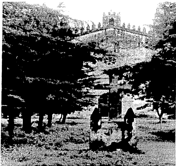
Documento fotográfico No. 5, en el cual podemos ver como era la cruz atrial que se encontraba en el atrio oriente del ex convento de Yecapixtla en el año de 1958, la cual fue destruida.
