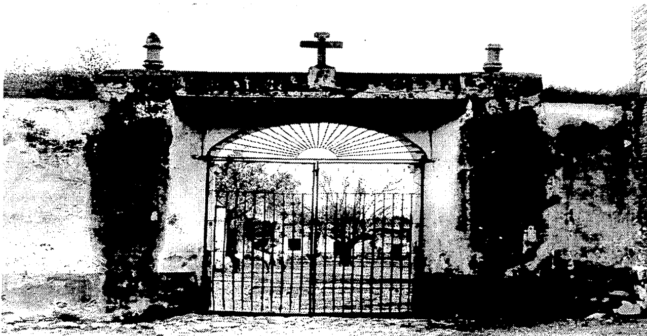
Documento fotográfico No. 13, el cual nos muestra la Arcada Real norte, fotografía tomada en el año de 1925 y atribuida a Don Manuel Ramos. Se puede apreciar también detrás de la reja, la tipología que prevalecía de la construcción en la población.
