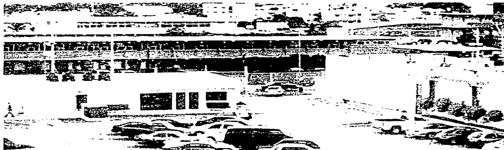
FIGURA 37: Vista aérea UAV, en primer plano el edificio de comunicaciones a la derecha, y a la izquierda un volumen de usos múltiples de servicio, y el estacionamiento.
