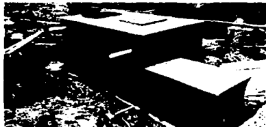
Figura 3.25. Tanque homogeneizador o segundo sedimentador del HAFVD
