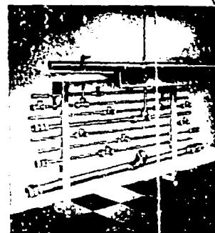
Gráfico- 3,2. Acomodo de los servicios generales para una mesa de laboratorio de pared (poyatas)
