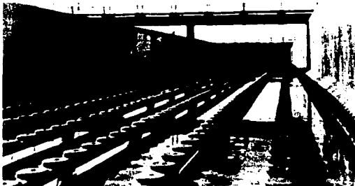
Fig 1 10 Tanque de aireación con difusores tipo domo (de Aerocor, co)
