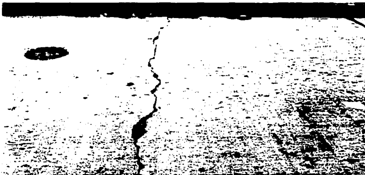
Fig. 2.52. Daños moderados de grietas transversales.
