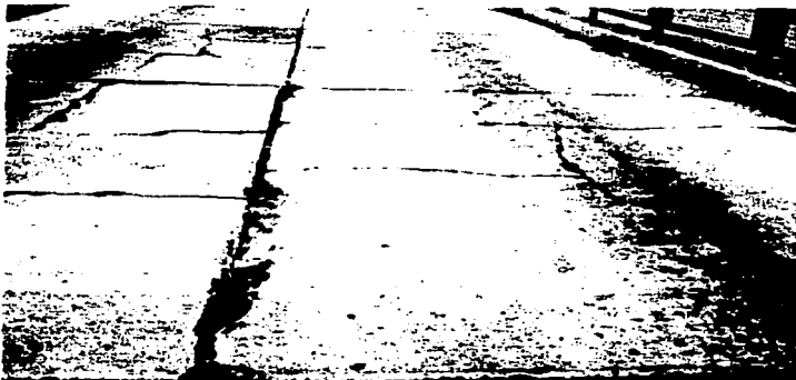
Fig. 2.50. Grietas longitudinales moderadas.
