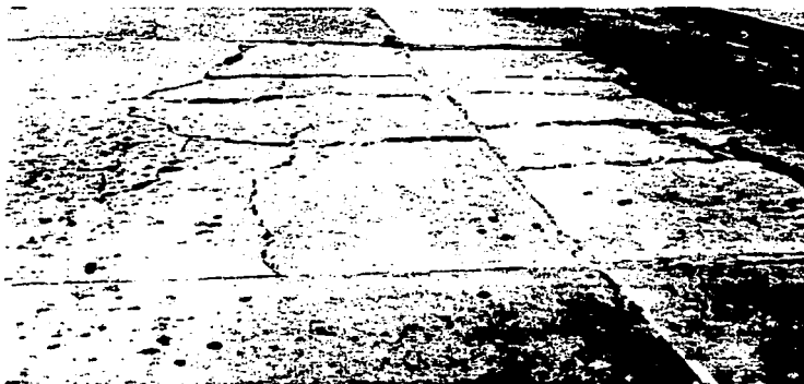
Fig. 2.62. Grietas en forma de mapa.
