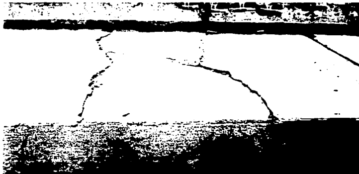
Fig. 2.53. Daños severos de grietas transversales.
