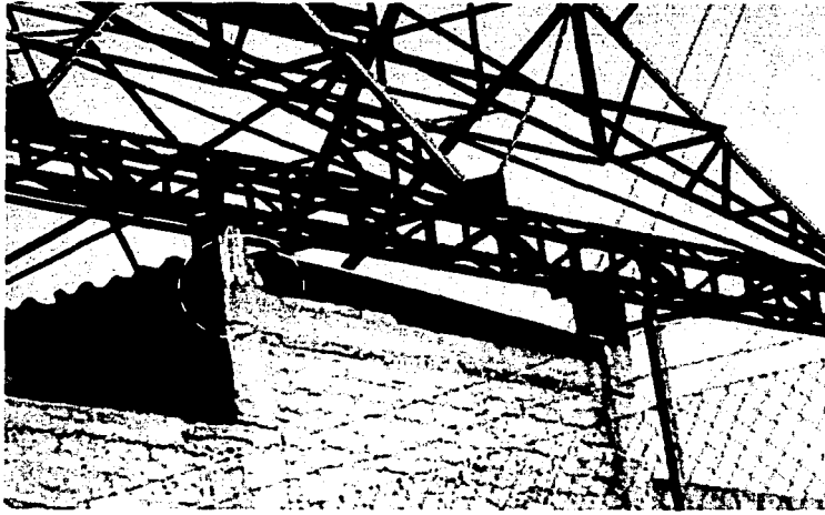
Fotografía 28.-Vista de apoyos del anuncio de azotea mostrado en la Fotografía 26. Estructura formada por ángulos de acero.
