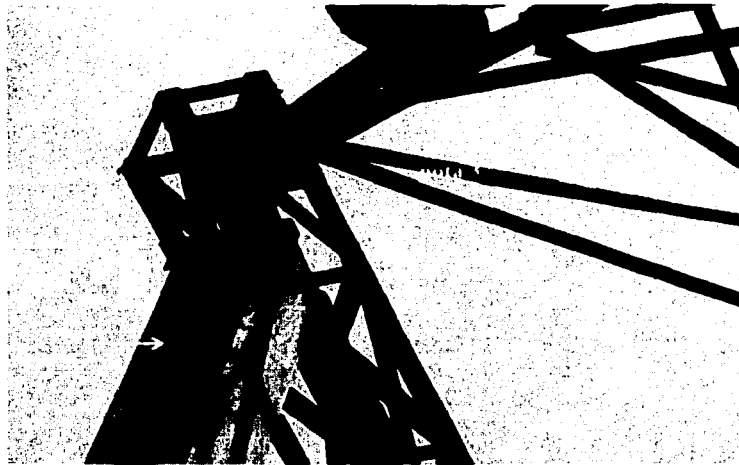
Fotografía 27.-Soporte del anuncio de azotea mostrado en la Fotografía 26.
