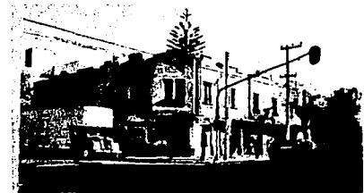
Vecindad Vivienda plurifamiliar, clase baja
