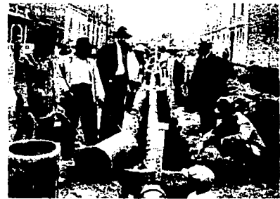
Instalación del sistema de drenaje
