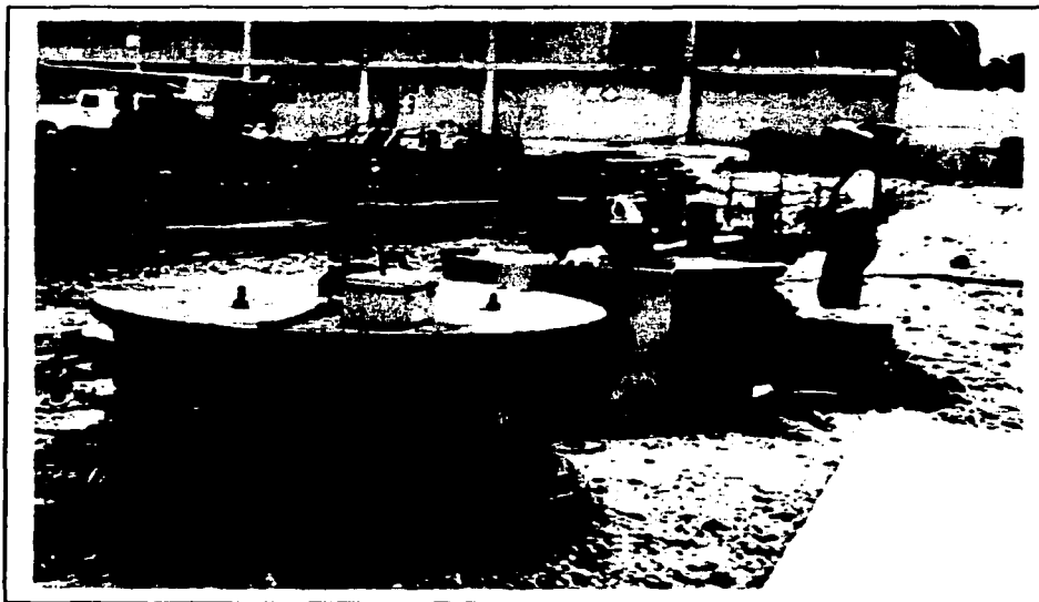
Figura VI.35 COLOCACIÓN DE TRES CELDAS DETECTORAS DE PRESIÓN
