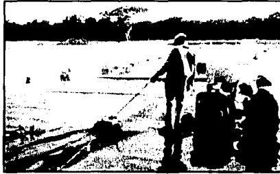
Figura 4.1.6 Unión de geomembranas por termofusión
