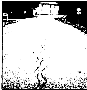
Figura 5.4.1 Asfalto agrietado en una calzada
