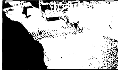
Figura 5.1.11 Procedimiento de tendido de geotextiles en un terraplén (G6refuerzo de geotextil, G1 refuerzo del suelo en capas)
