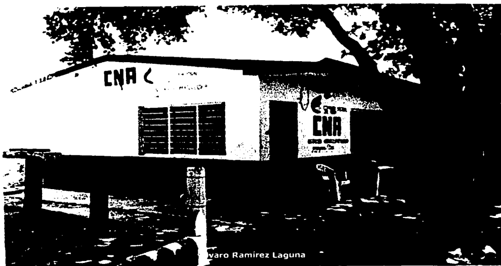
Aspecto general de la instalación de la estación hidroclimatólogica "Pijjilapan", a la altura del puente de la carretera federal costera, en la considerada desembocadura de la cuenca.
