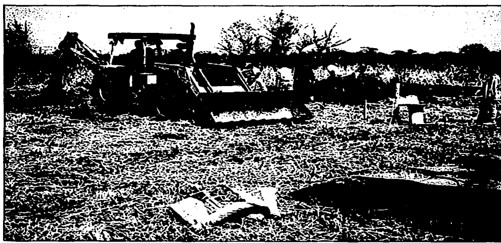
Fig. 7.20.- Excavación de las zanjas para la colocación de electrodos en los extremos de la línea fuente.
