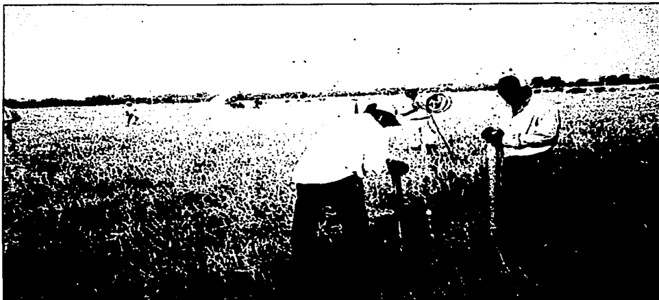
Fig 7.25 - Colocación de las bobinas receptoras
