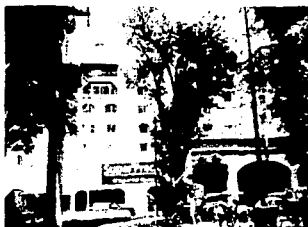
12. Construcción de nuevas viviendas discordantes con el contexto
