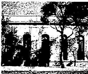
11. Fachada característica de las viviendas de Santa María la Ribera.
