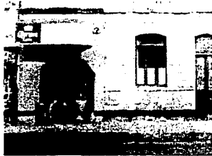
7. Fachada deteriorada por acondicionamiento de restaurante
