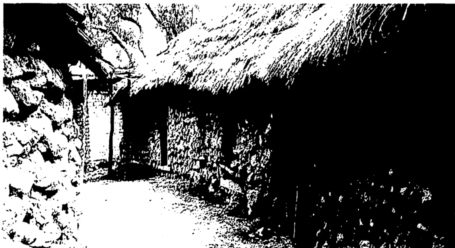
Foto: Casa de adobe típicamente huichola en Keruwitla . Las Latas, Comunidad de Santa Catarina, Jalisco. Foto de Regina Lira.
