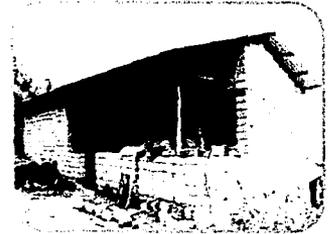
Uno de los elementos producto del desarrollo de una técnica y parte de los elementos del territorio, son los muros de barenque, compuestos por líneas de carrizo , sujetas apilares de madera que sostienen la estructura del techo. Este entramado de líneas sirve de soporte para aglutinar una masa consistente formada por piedras y tierra mezclada, el cual es utilizado para cubrir la estructura en su totalidad.
