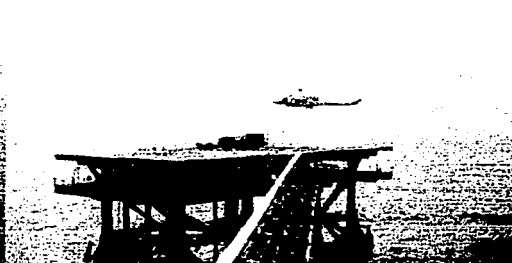
Fig. 13 Helipuerto en Plataforma Habitacional
