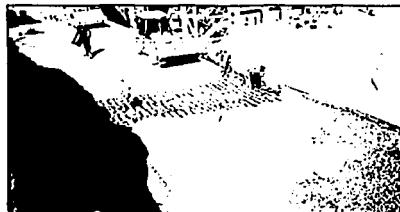
Figura 5.1.11 Procedimiento de tendido de geotextiles en un terraplén (G1 refuerzo de geotextil, G6 refuerzo del suelo en capas)
