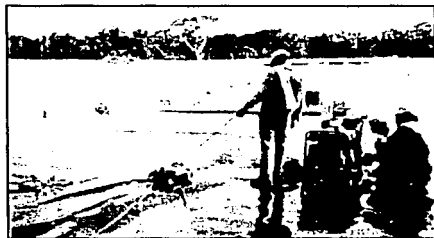
Figura 4.16 Unión de geomembranas por termofusión
