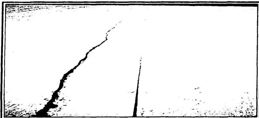
Figura 2.1. Grietas tipo estructural.
