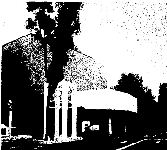
FOTO No. 11 AMPLIACIÓN DE EL ACCESO DE EL TEATRO JULIO CASTILLO CON LA ELIMINACIÓN DE LA TAQUILLA AHORA UBICADA A UN COSTADO.
