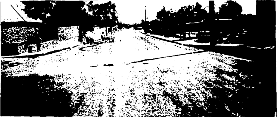
Av Lázaro Cárdenas de la Col. Lázaro Cárdenas, San Juan Zitlaltepec. Obra terminada.
