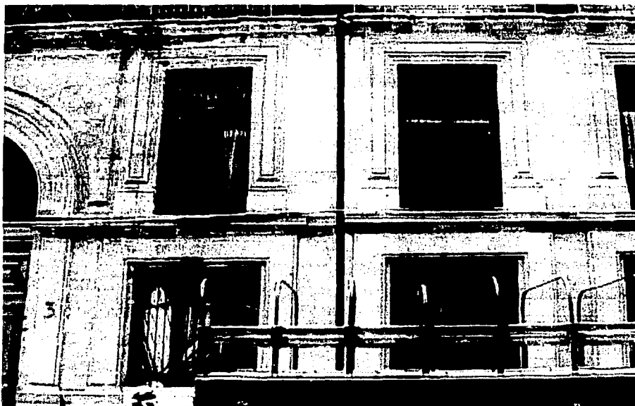
Foto 16. Junta constructiva sobre la fachada Norte del Palacio Nacional
