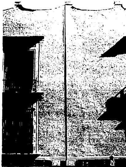
Foto 14. Junta constructiva en la fachada sur del Palacio del Ex Arzobispado
