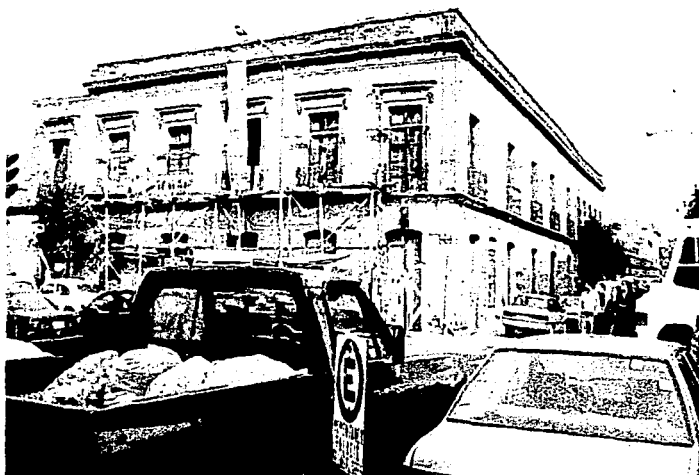
Foto estado actual del inmueble, 2002
