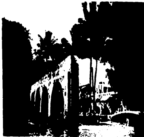
Acueducto de la Hacienda de Temixco
