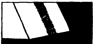
Indicación de una falla en una soldura
