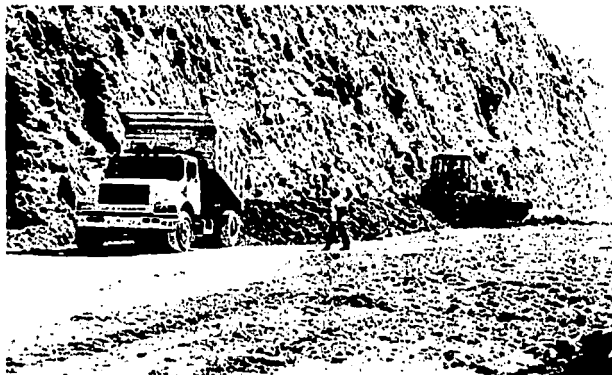
Fotografía No. 12 Maniobras en las que se aprecia el proceso de descarga y tendido de material pétreo.
