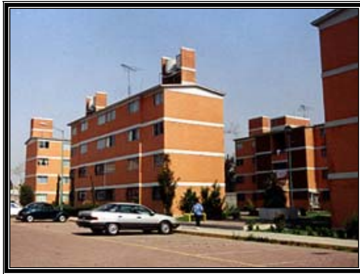
Figura 1.17 Conjunto habitacional Bosques de Alba II, Cuautitlán Izcalli, Méx; ejemplo de los actuales sistemas de edificación con mampostería
