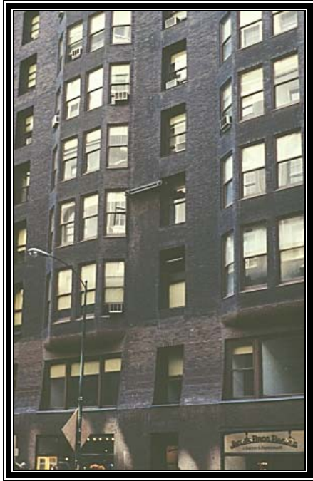
Figura 1.16 Edificio Monadnock, Chicago. Edificio de 17 niveles de mampostería no reforzada
