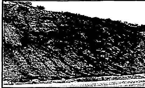
Figura 2.3.6 Geomalla para proteger carreteras de la caída de rocas
