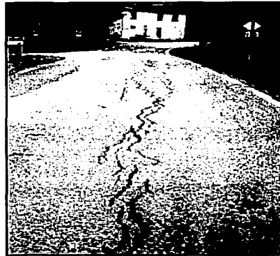
Figura 5.4.1 Asfalto agrietado en una calzada
