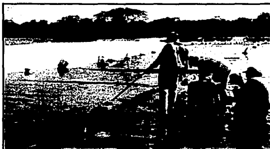
Figura 4.1.6 Unión de geomembranas por termofusión
