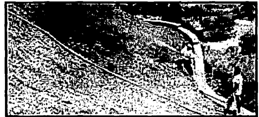
Figura 2.3.5 Geoestera tridimensional, esta diseñada para la protección y vegetación de taludes sujetos a la erosión superficial
