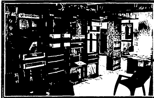
Fig. IV.3 Fotografías de equipos instalados en el cuarto del switch.
