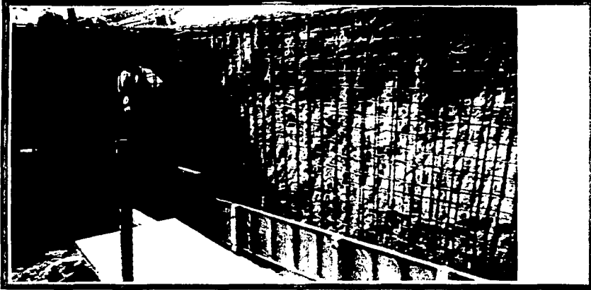
Fig. III.11 Fotografía del proceso de colocación de acero de refuerzo para la cimentación de una torre.
