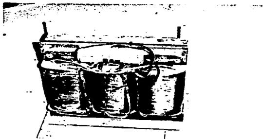
**Figura 1.1.7 Transformador de Instrumentos**
