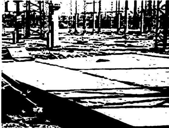
**Figura 5.4 Base de Concreto para Transformador**
