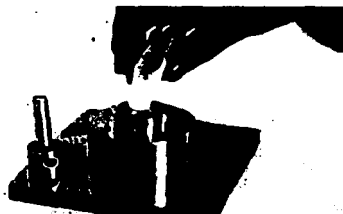
Fig7. Adición del polvo a la cavidad de la matriz.
