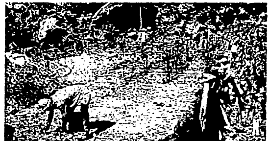
Fig.6.13 Preparación del siguiente nivel de gaviones
