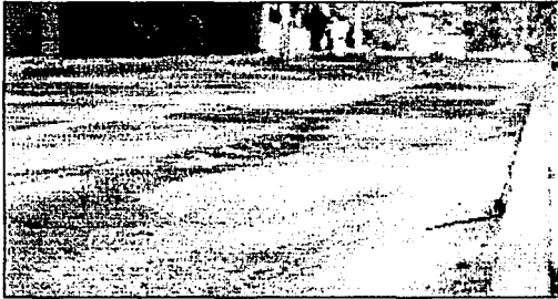
Figura 20.- Las roderas son fallas comunes de un pavimento flexible. provocadas por altos volúmenes de tránsito a bajas velocidades.
