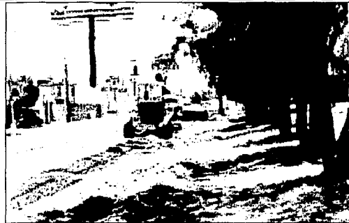
Figura 140 Trabajos de extendido y compactación de material para subbase.
