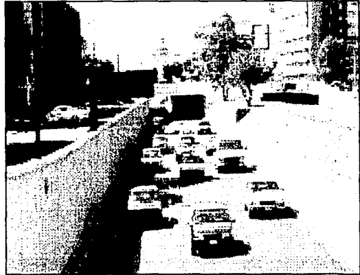
Figura 25.- El viaducto de la ciudad de México.
