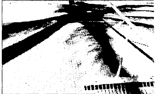
Figura 181.- Peine con dientes metálicos para texturizado transversal manual.
