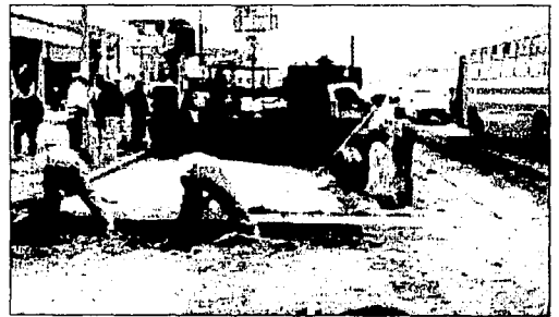
Figura 163.- Inicio de un colado con la pavimentadora de cimbra deslizante.
