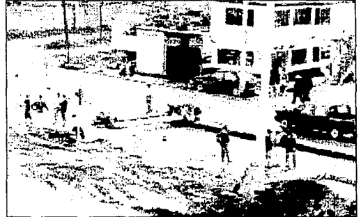
Figura 166 Rodillos compactadores de concreto sobre cimbra fija.
