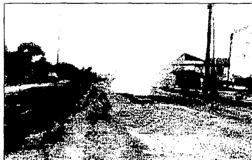
Figura 142 Estabilización de la subbase mediante la integración del cemento al material de banco.
