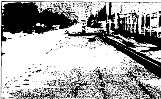
Figura 144 Tramo compactado y estabilizado listo para recibir el riego de sello con emulsión asfáltica.
