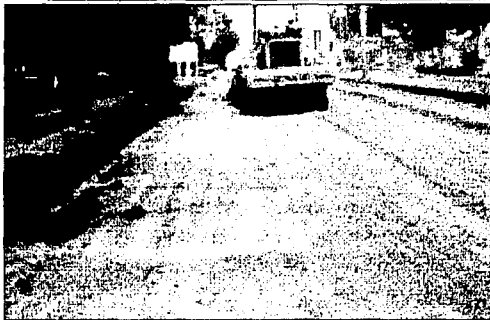
Figura 140 Trabajos de extendido y compactación de material para subbase.
