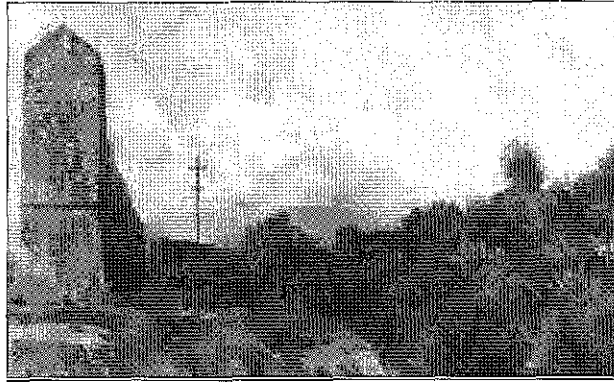
Fig. 11.25 Acueducto de Tizapán hacia 1920.
