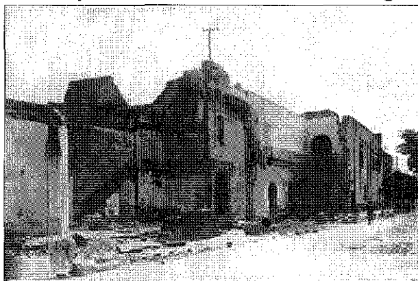
Fig. 10 29 Demolición del convento de San Sebastián de la ciudad de México.
