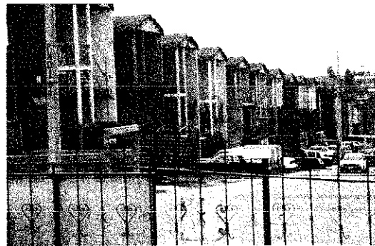
Vivienda mínima en torre de tres niveles, ubicada en la periferia de una ciudad media.
