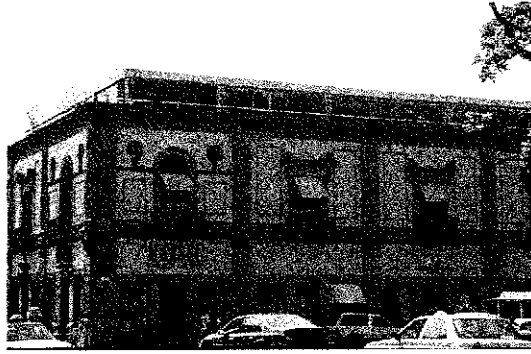
Intervención sobre edificio catalogado, ubicado en un centro histórico.
