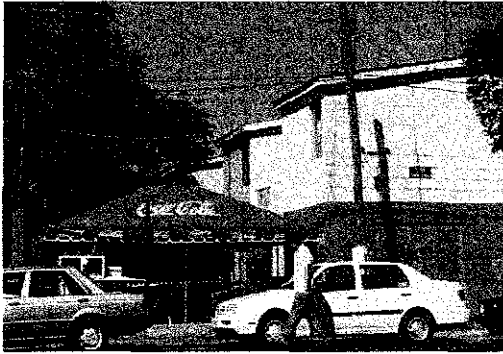
Vivienda mínima duplex con anexo comercial, dentro de un conjunto habitacional en una zona media:
