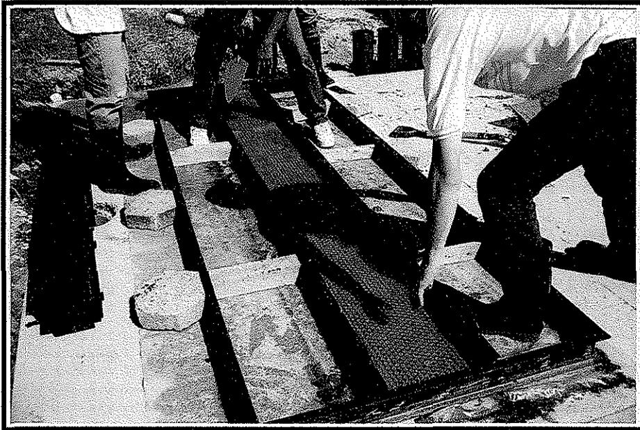
**FIGURA 3.5 Colocación de la malla de refuerzo en especímenes Tipo A**
