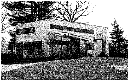
i.58 Casa de Walter Gropius En estas dos obras se aprecia la intención del arquitecto por hacer una integración entre el edificio y el entorno en el que se encuentra.
