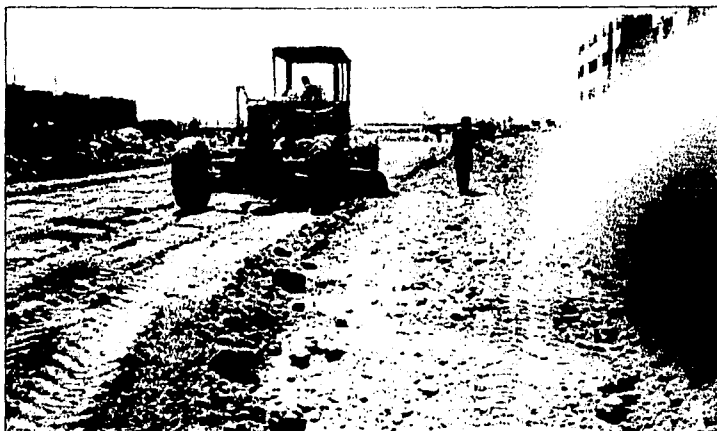
FOTOGRAFÍA No. 6 (CONSTRUCCIÓN DE BASE HIDRÁULICA CON GRAVA CONTROLADA)
