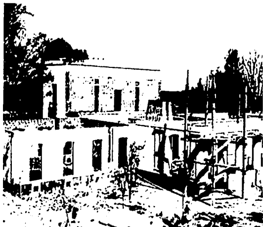
CONSTRUCCION DEL OBSERVATORIO EN TACUBAYA
