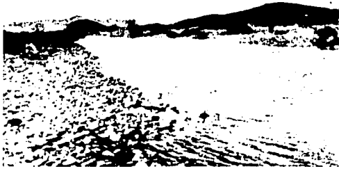
Fig. 4.13. Fondo de canal en cantos rodados, donde no hay suficiente arcilla en el agua o donde existe una velocidad muy alta, que impide la formación de un lecho liso bien gradado.
