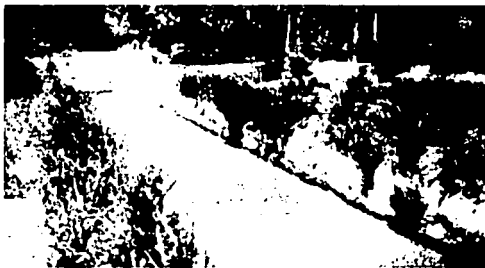
Fig. 4.10. Zanja o cuenca revestida en ambos lados y en el fondo con piedra partida acomodada en seco. Fondo bastante irregular, con algunos cantos rodados sueltos.
