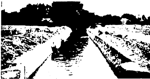
Fig. 4.9. Revoque o pañete de cemento aplicado directamente a la superficie tratada de un canal en tierra. Con malezas en los lugares dañados y arena suelta en el fondo.
