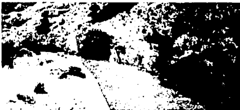
Fig. 4.11. Canal excavado a media ladera con la banca superior cubierta por raíces de sauces y a la banca inferior con un muro de concreto bien terminado. Fondo cubierto con grava gruesa.
