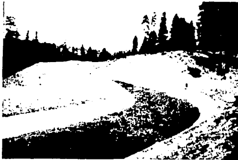
Fig.4.2 Canal de concreto vaciado por detrás de una plataforma móvil para nivelación y pulimento superficial.
