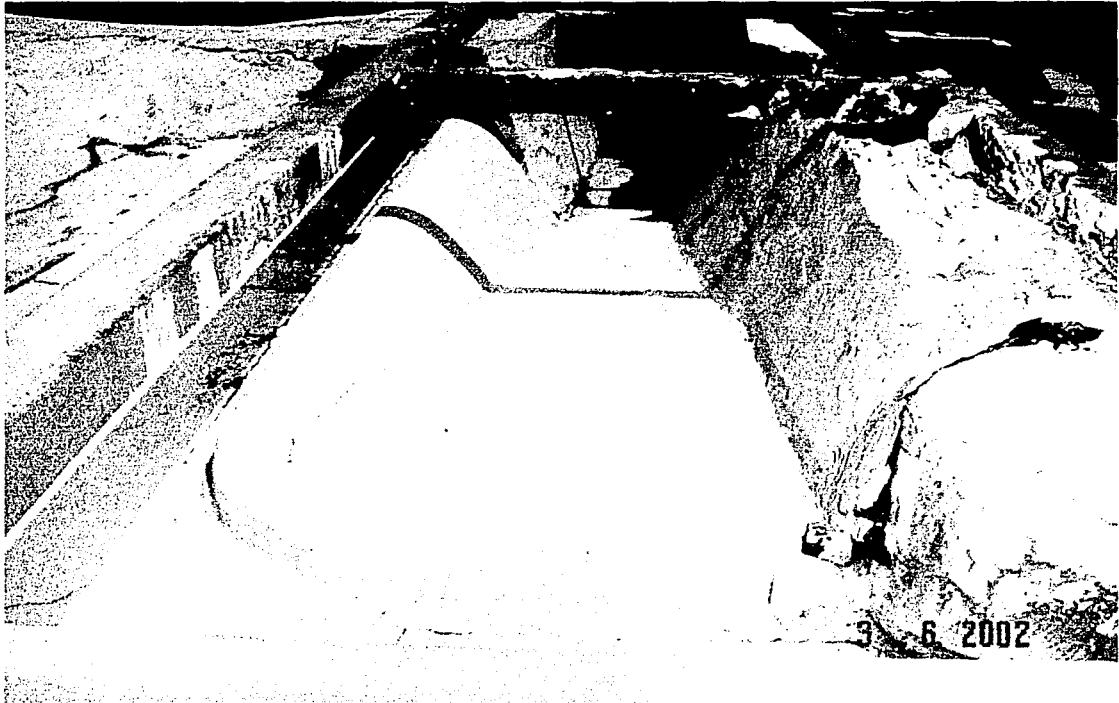
Figura 7.6. Vista desde aguas arriba del canal con modificación.
