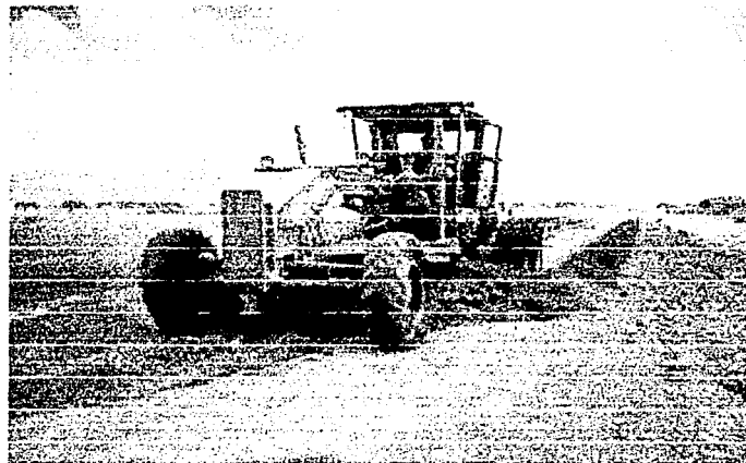
Figura 2 Construcción de terracerías
