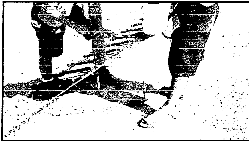
Figura 9. Ajuste con plomada de línea guía.
